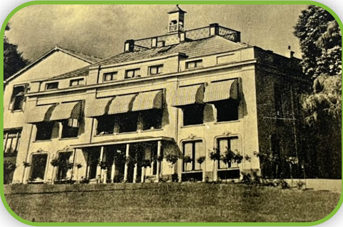
Eerste gebouw van Kalorama
